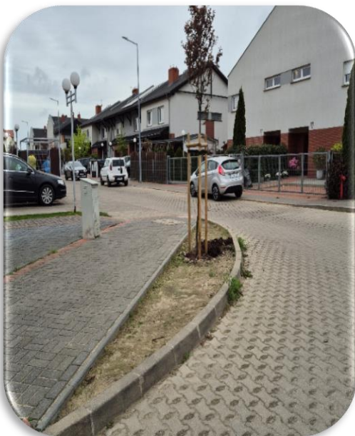
Odbetonowywanie Osiedla Parkowego
