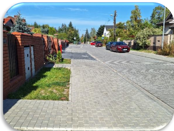
ul. Dojazd w Plewiskach
