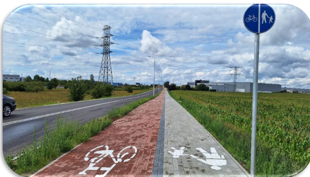
ul. Towarowa w Komornikach
