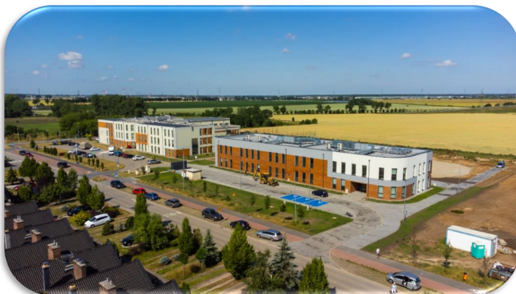
Rozbudowana Szkoła nr 2 w Plewiskach
