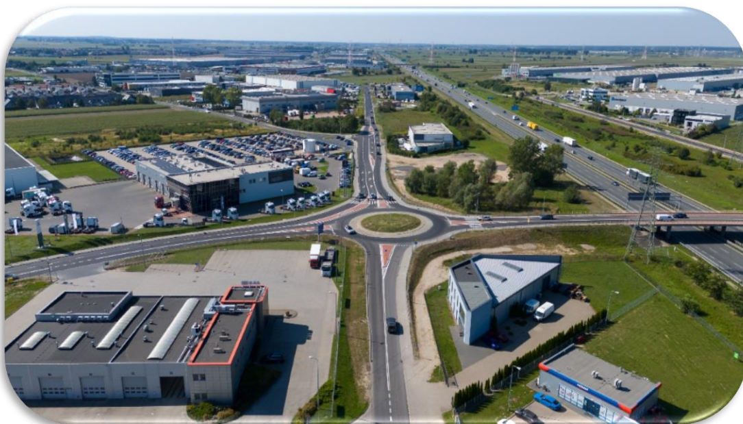
Przebudowa ul. G. Daimlera w Komornikach
