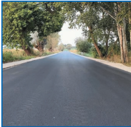
Ulica Bukowa na odcinku Walerianowo-Rosnowo już po pracach
