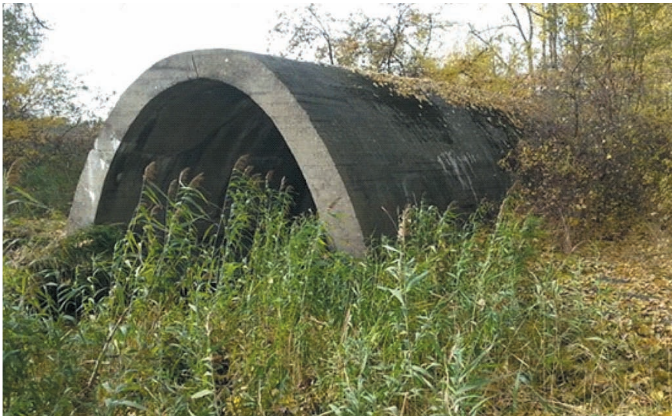
Czołowa fasada mostu, wyrastającego znad rzeczki Wirynka od strony miejscowości Wiry – początek XXI wieku.
