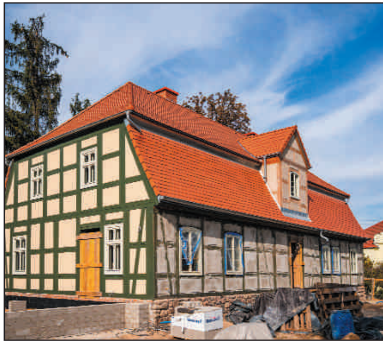
Kończy się przebudowa, remont i modernizacja zabytkowej plebanii zwanej organistówką.
