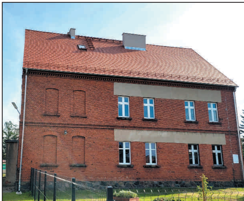
Remont dachu starej szkoły w Chomędicach
