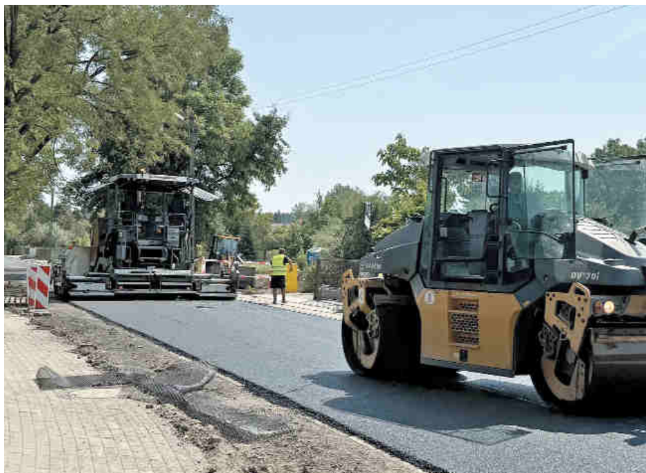
ul. Kościelna w Komornikach
