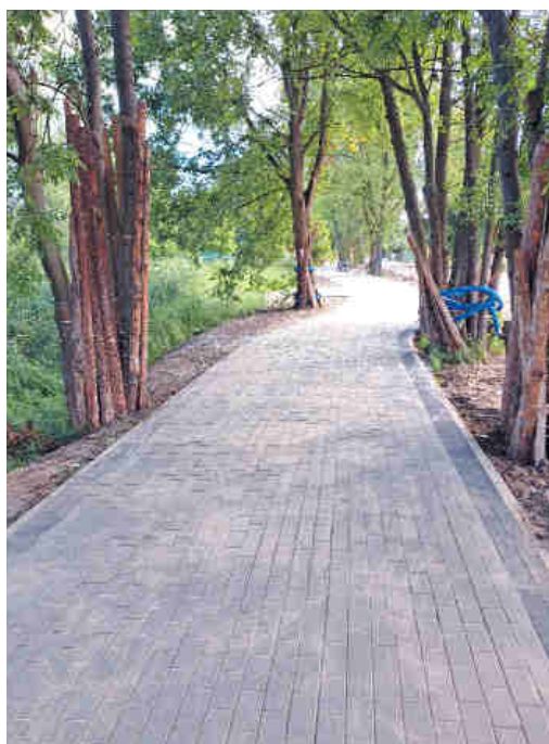
Chodnik przy ul. Kościelnej
